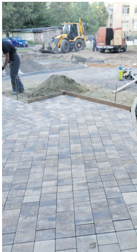
■ Наличная ул., дд. 23–25. Благоустройство территории
